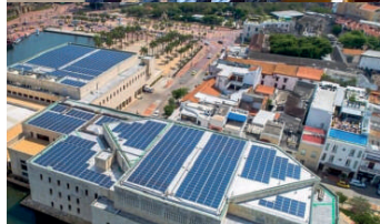
Energía Solar Centro de Convenciones
